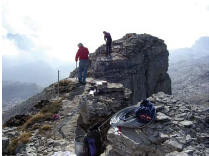
Intervento sulla via ferrata "G. Vidi" n. O390, Gruppo di Brenta
